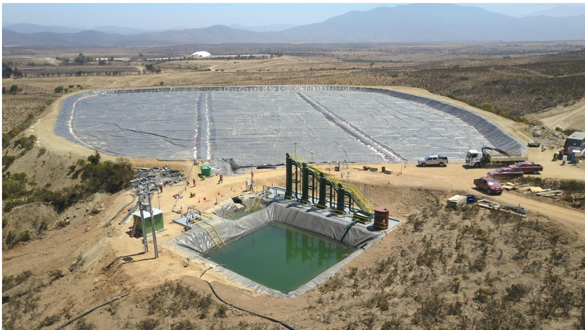
Figura 6.42: Vista general de la planta piloto construida.
