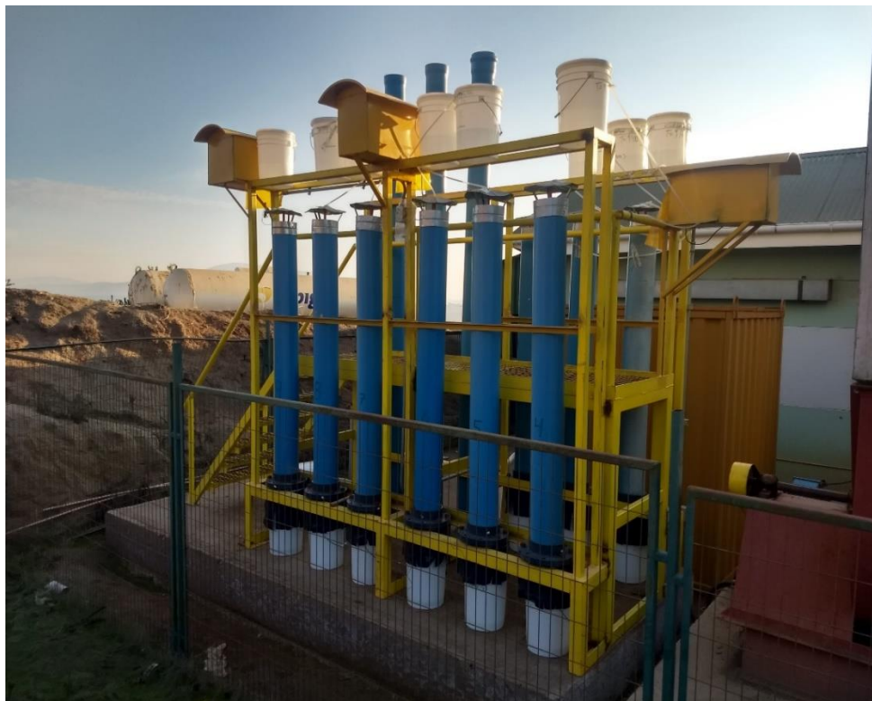
Figura 9.24: Estructura metálica de soporte de columnas.
