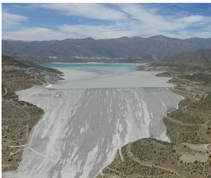
Figura 5-1: Muro perimetral tranque de relaves, levantado con fracción gruesa obtenida mediante proceso de ciclonaje.
