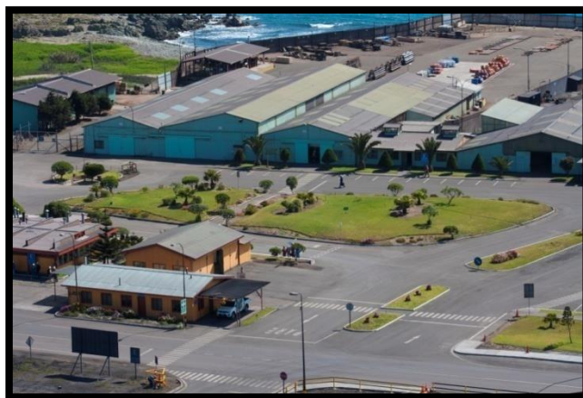
Figura 1 – 9: Oficinas corporativas de prevención de riesgos, bodega de materiales y equipos
