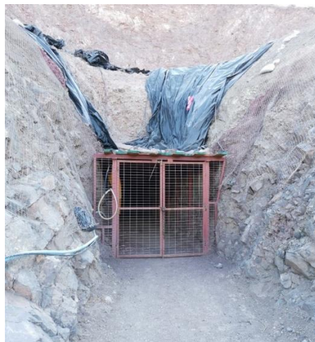
Figura 3-1. Acceso a túnel 657 Mina Cerro Negro del 1 al 12
