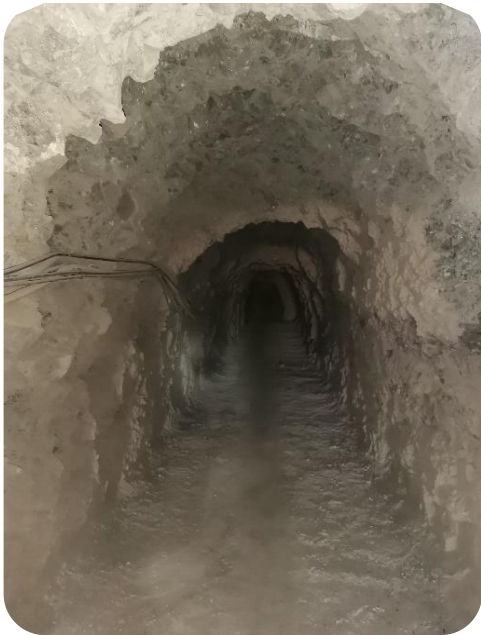
Figura 3-9. Vista interior del túnel 657 (sin sistema de fortificación)
