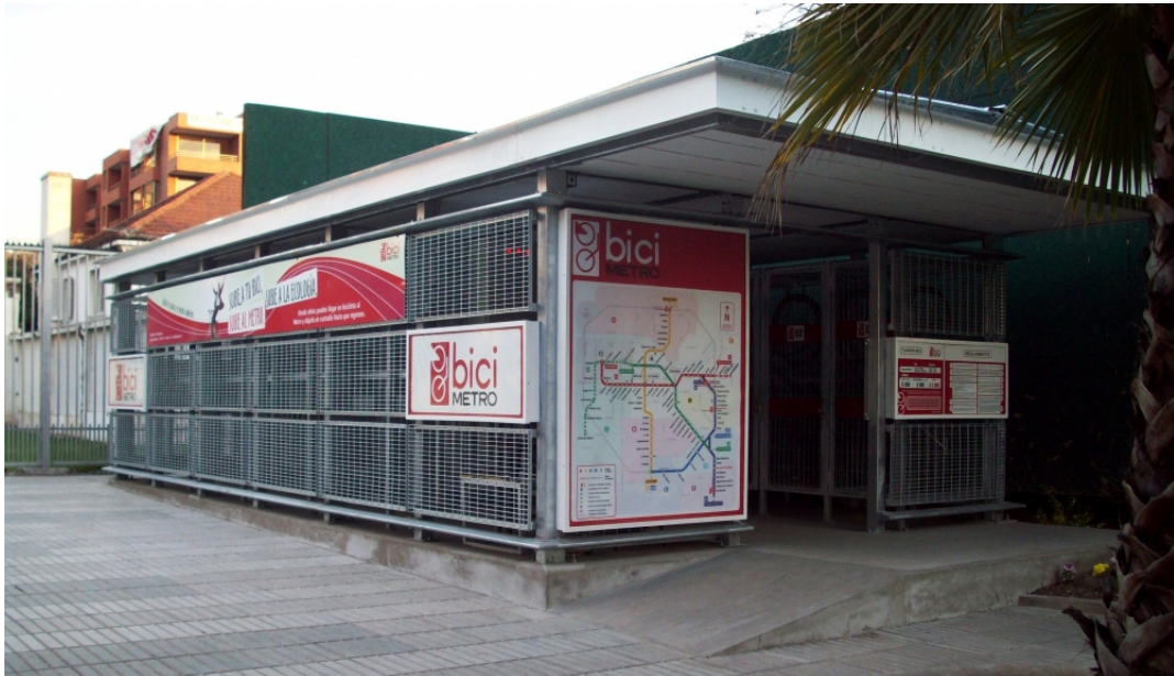
Fig. 2.9: Estacionamiento Metro de Santiago
