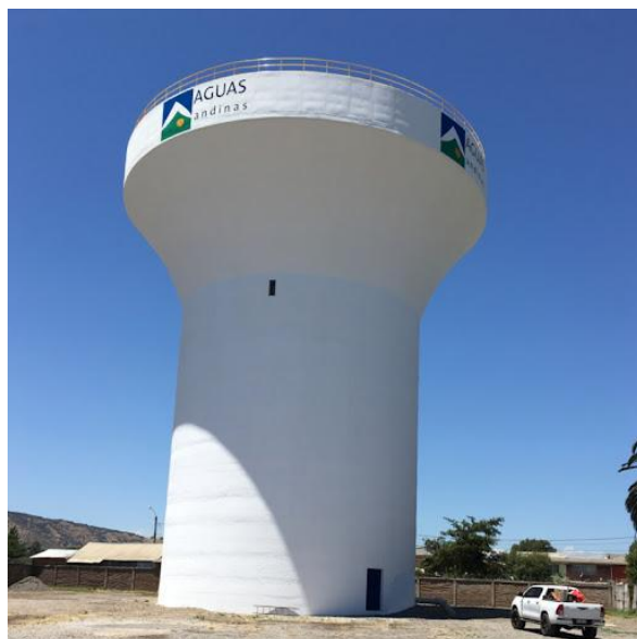
Figura 1-1: Estanque elevado construido en Chile. Fuente: Google imágenes.
