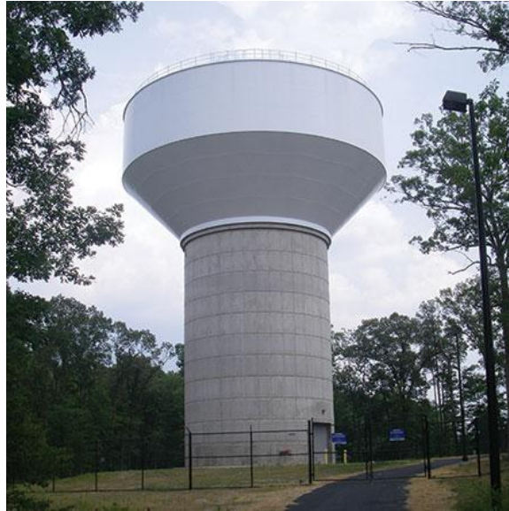
Figura 2-2: Estanque elevado con soporte de pedestal. Fuente: Google.
