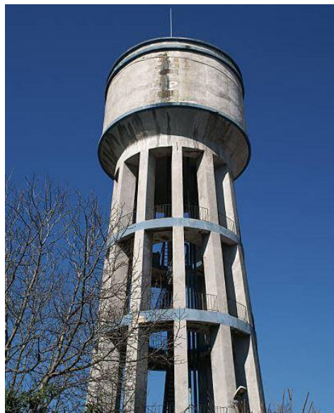
Figura 2-1: Estanque elevado con soporte de marco. Fuente: Google.
