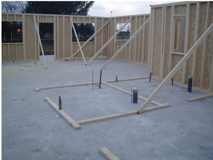
Figura 27: Instalación tabiquería.
