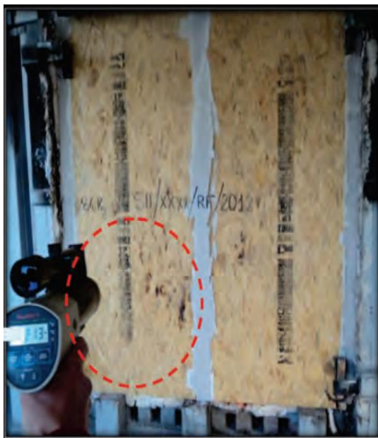
Figura 23-1: Ensayo resistencia al fuego
