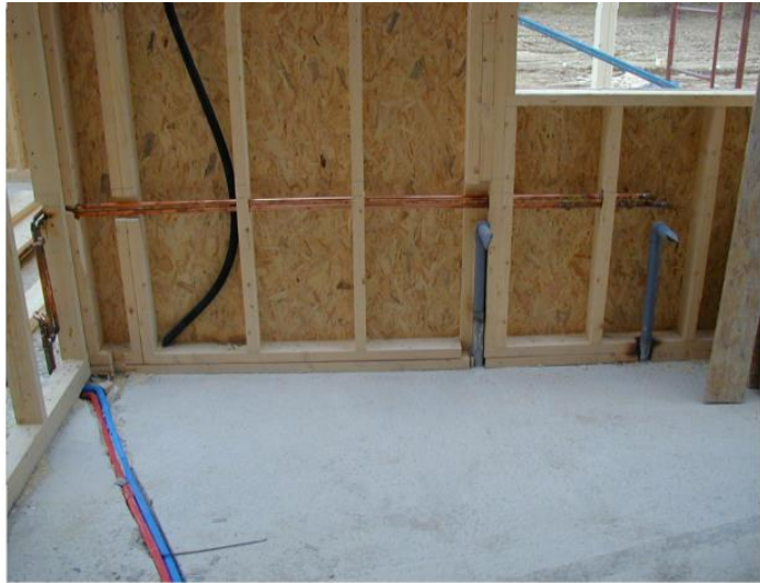
Figura 28: Canalizado eléctrico y potable
