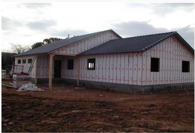
Figura 34: Termino de instalación cubierta.
