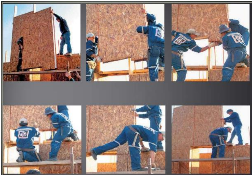
Figura 16: Montaje paneles SIP. Fuente: Portalonda.cl
