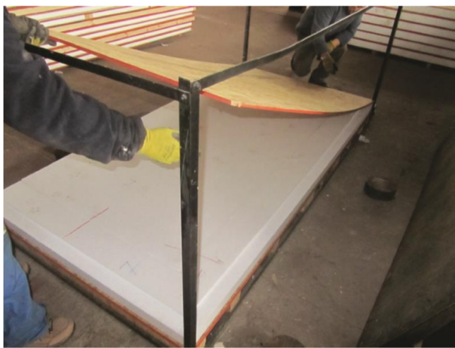
Figura 11: Proceso unión paneles.
