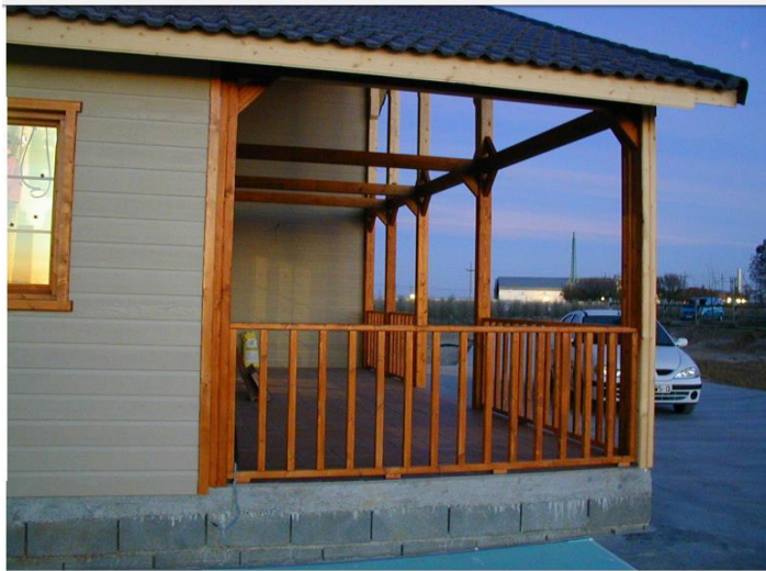
Figura 35: revestimiento exterior y termino.
