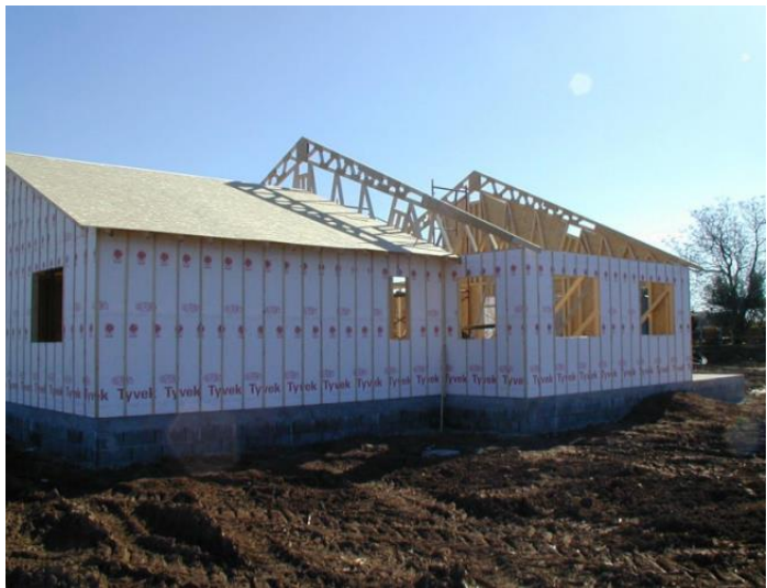
Figura 33: Revestimiento cerchas y barrera de humedad.
