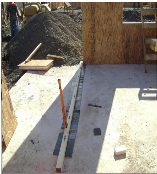
Figura 36: Anclaje solera inferior y canalización eléctrica.
