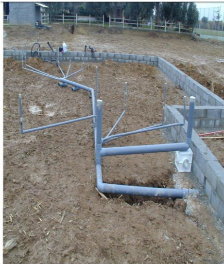
Figura 25: Instalación redes sanitarias.
