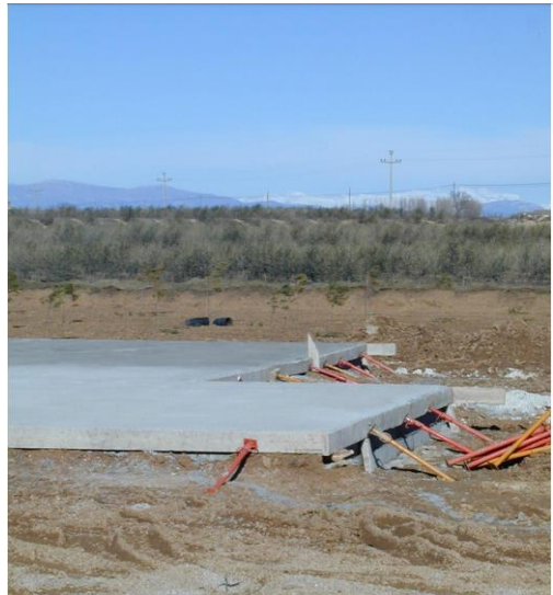
Figura 26: Hormigonado cama radier.
