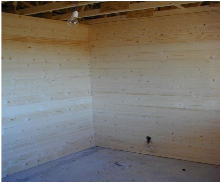
Figura 29: Revestimiento interior.
