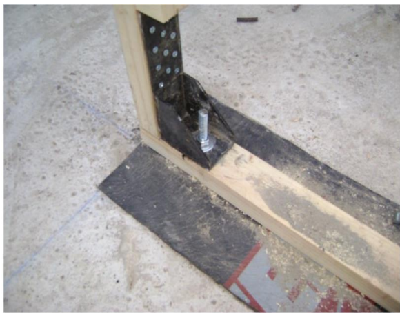
Figura 39: Anclaje AN en solera inferior
