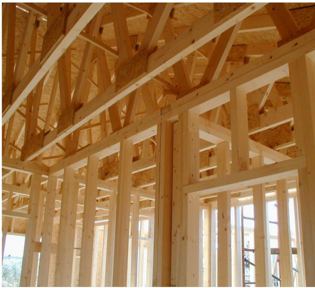
Figura 32: Instalación cerchas y revestimiento cubierta.
