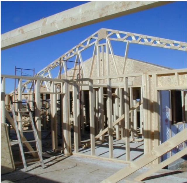
Figura 31: Instalación cerchas.
