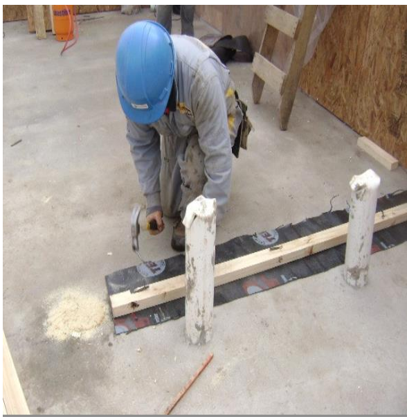
Figura 37: Anclaje solera inferior.
