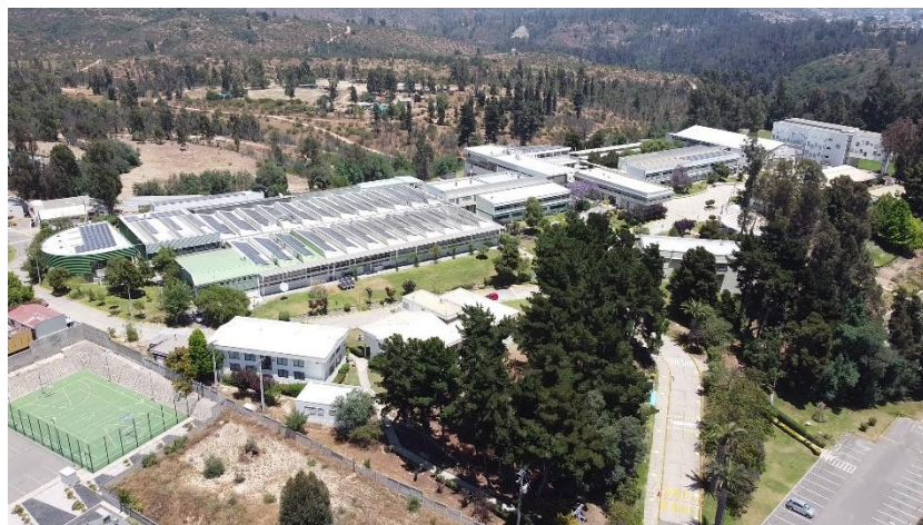
Figura 1.5: Infraestructura de USM Sede Viña del Mar.
