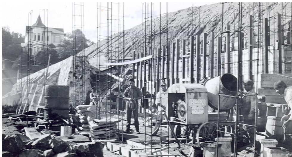
Figura 1.1: Primeros avances en la construcción de la USM Valparaíso.
