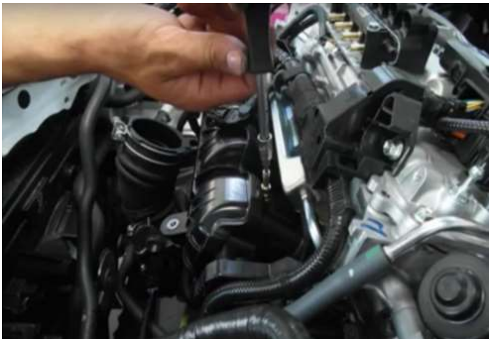
Figura 3- 8: Instalar difusores
