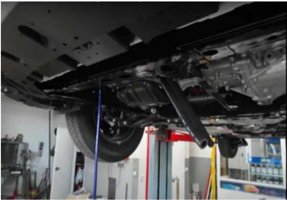
Figura 3- 16: Instalar tubos refrigeración del evaporador
