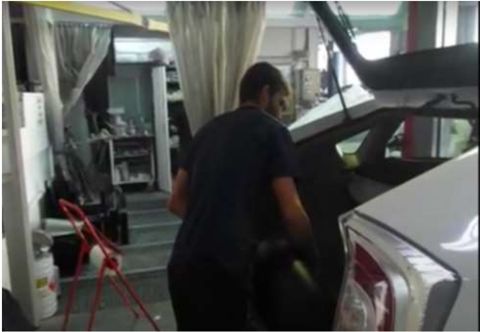
Figura 3- 20: Instalar deposito GLP
