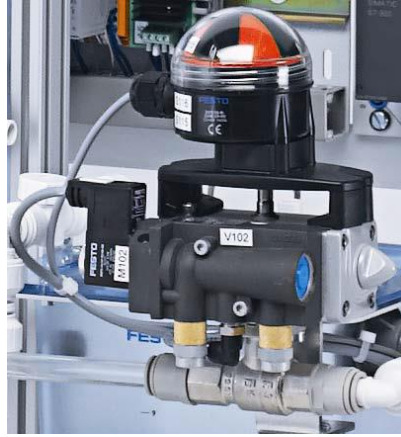
Figura 2-5. Válvula de bola de dos vías con accionamiento rotativo neumático
