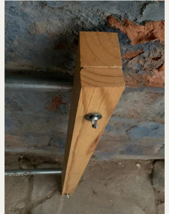
Detalle de unión con tuerca mariposa
