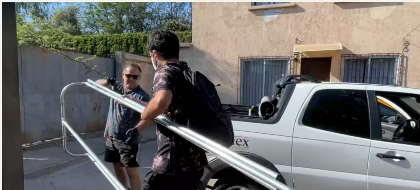
Cargando materiales de la intervención a las 10 am aproximadamente
