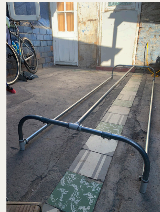
Primera parte Etapa 3 de armado
