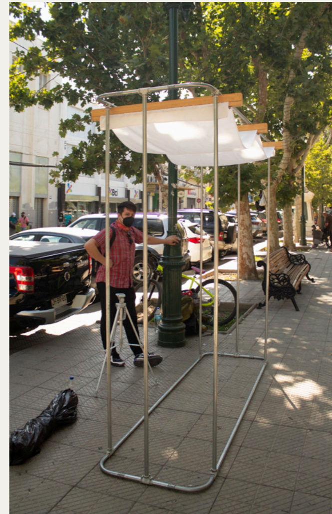
Estructura armada previo a montaje
