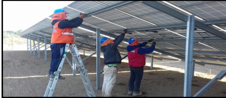
Figura 2-15. Cuadrillas de trabajo montando paneles fotovoltaicos
