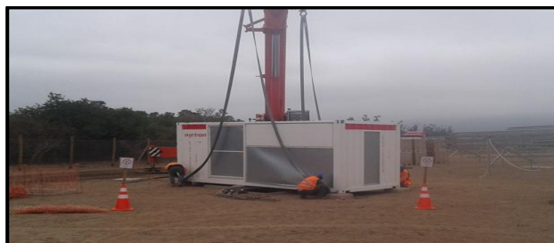
Figura 2-17. Centro de Transformación de la planta solar FV
