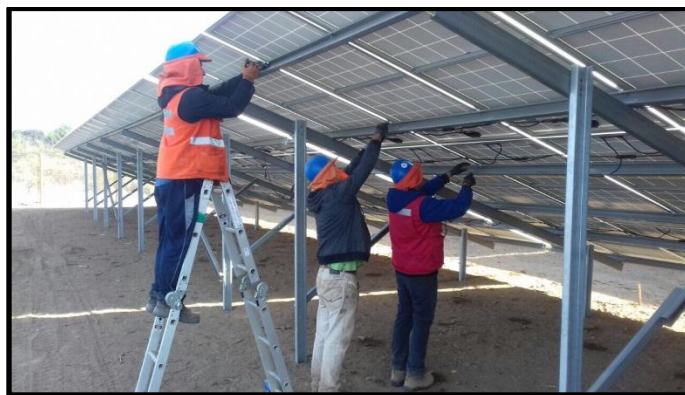
Figura 1-7. Montaje de paneles fotovoltaico.
