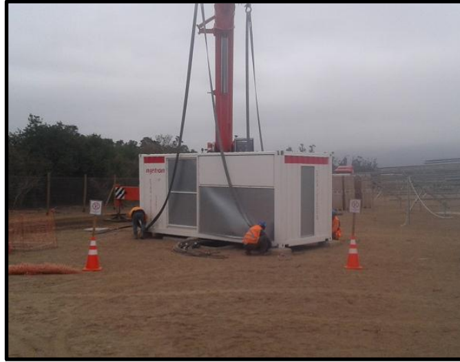
Figura 3-8. Centro de Transformación
