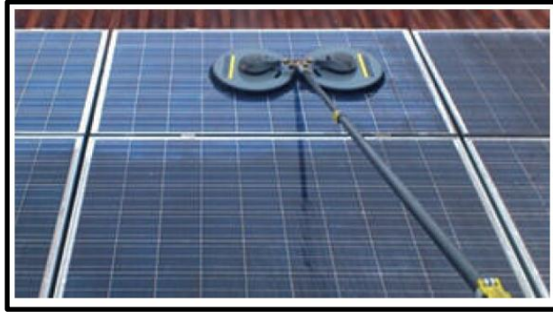
Figura 3-1. Limpieza de paneles
