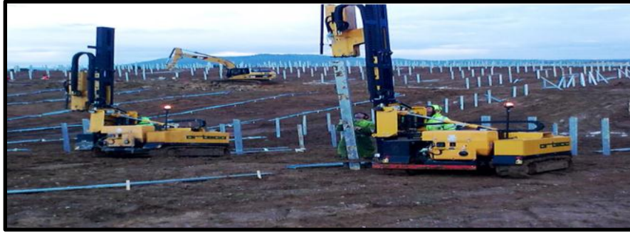
Figura 2-12. Máquina hincadora de postes en parque fotovoltaico
