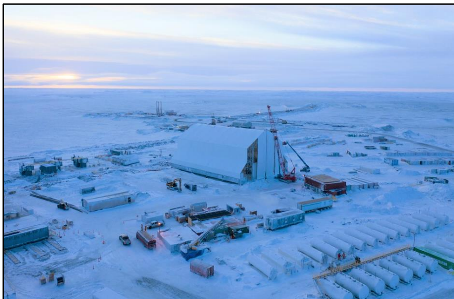
Figura 4: Centro de mantenimiento del proyecto de extensión Amuraq. (Agnico Eagle, 2021)
