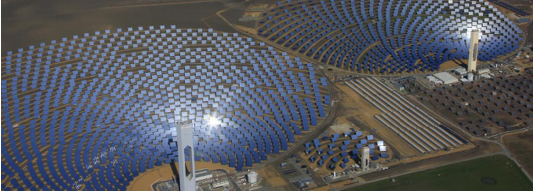
Figura 14: Planta solar Atacama-1 en la segunda región.
