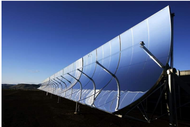
Figura 11: Colector PTC en instalación de SEGS III, California.
