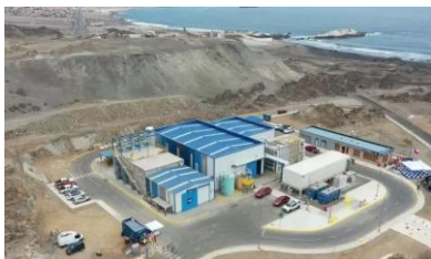
Figura 5.1. Planta Desaladora Tocopilla
