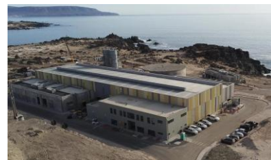
Figura 5.3. Planta Desaladora de Agua de Mar de Atacama
