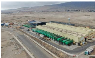
Figura 5.2. Planta Desaladora Norte
