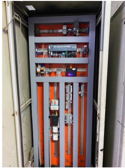
Figura 4-9 Tablero de control, con PLC S7-1500 (existente), al cual se agregaron módulos digitales, Base unit y remotos para el diseño e implementación del control de bombas de agua y petróleo y nivel del estanque diario de petróleo.
