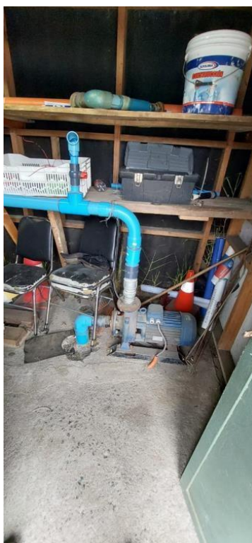
Ilustración 7 bomba principal sistema de riego, fuente: UTFSM sede Concepción
