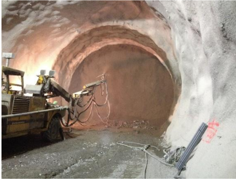
Figura 1. Proyección de HRF en túnel minero en Chile.
