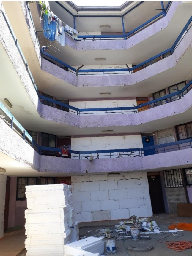
Figura 2-18. Instalación de planchas de Aislapol.
