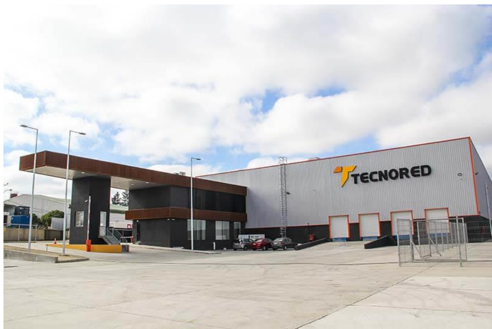
Ilustración 1: TECNORED S.A. - Centro de Distribución Curauma, Valparaíso.
