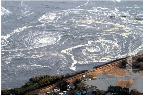
Fig. 2.2: TCS en Fukushima durante el tsunami de Japón, 2011. Fuente: Borrero et al., 2015.
