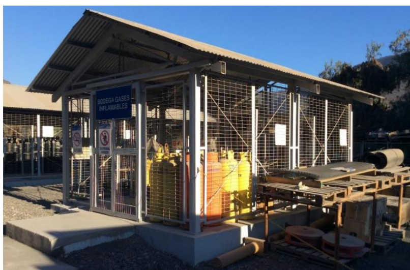
Fuente: Fotografía Bodega de gases inflamables Ilustración 3-2. Bodega 1, de gases inflamables
