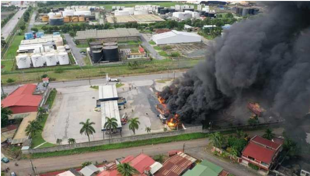
Figura 3-8: Accidente Estación de Servicio en Guatemala
