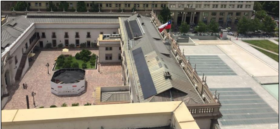
Figura 4.3 - Azotea del Palacio de La Moneda, donde se puede observar la techumbre con Paneles Fotovoltaicos. Fuente: minenergía.cl
