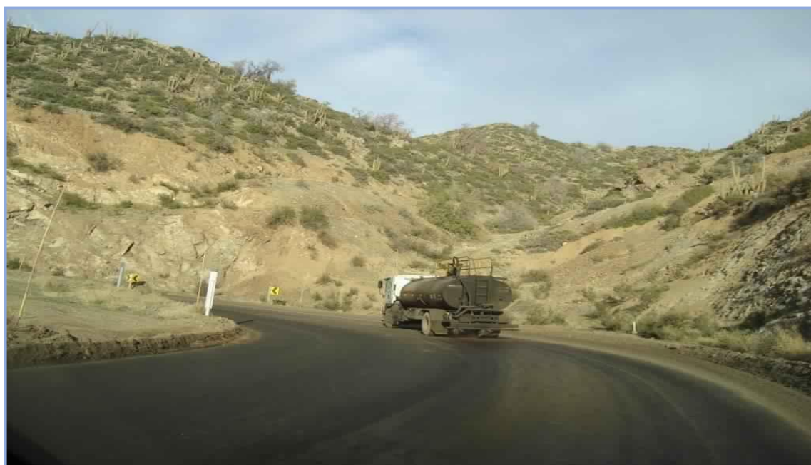
Figura 2-5. Camión aljibe rociando el producto PETROSOIL.
