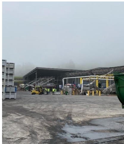
Figura 3-1: Patio central de la planta.
