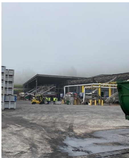
Figura 1-4: Patio central de la planta de procesos.
