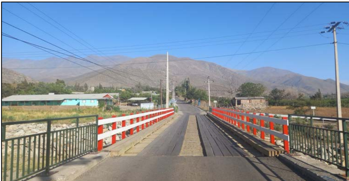
Figura 3-8: Fotografía del acceso poniente al Puente Cuncumén
