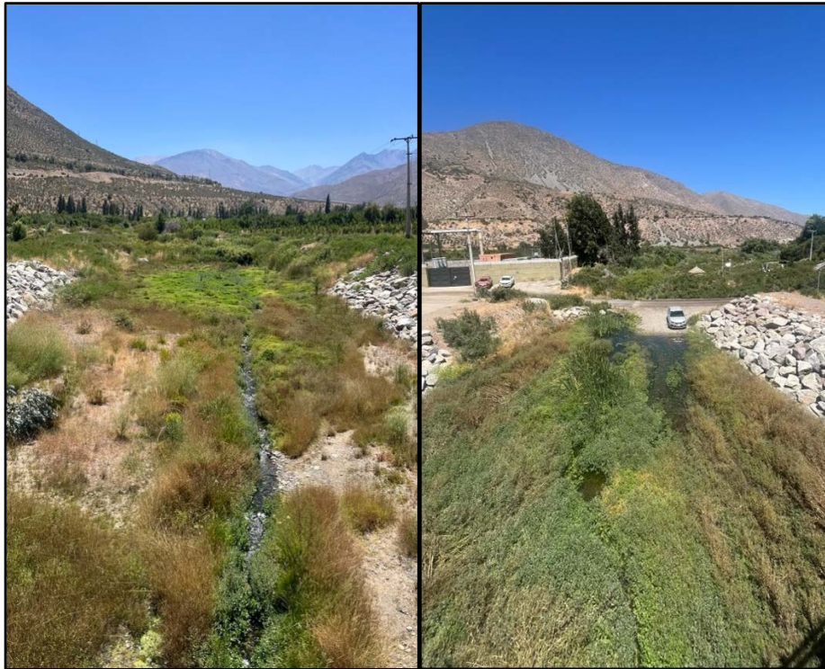
Figura 3-2: Vista desde Puente Cuncumén Aguas Arriba (Izquierda) y Aguas Abajo (Derecha)
