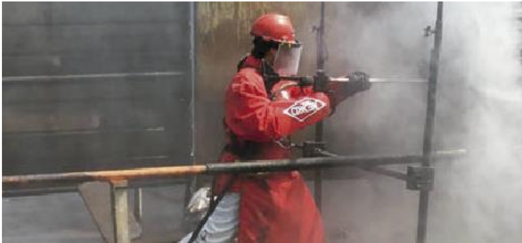
Figura 1-4 Operador de limpieza con alta presión
