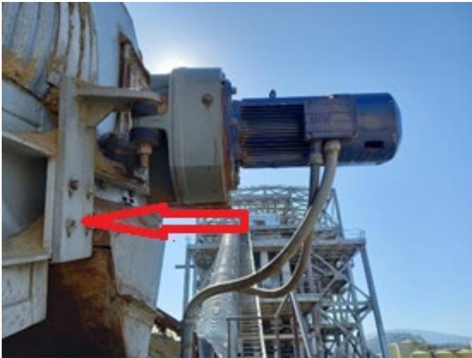
*Figura 3- 7 Modelo soporte a fabricar*
