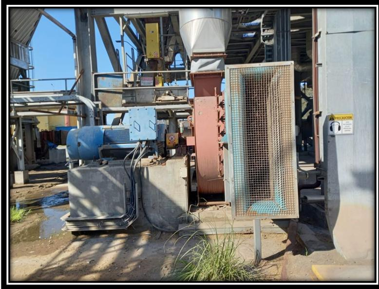
*Figura 1- 26 Ventilador aire primario*
