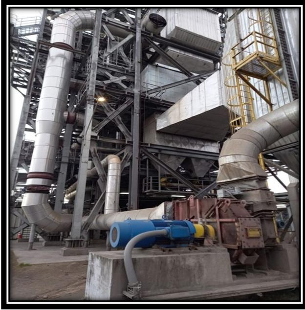
*Figura 1- 27 Ventilador aire secundario*
