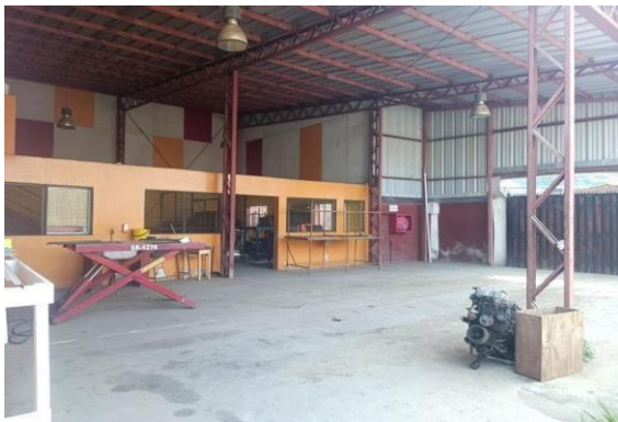
Figura 1-1. Vista frontal instalaciones Av. Palmira Romano Norte 240
