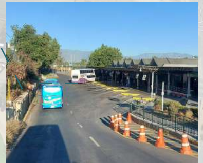
Fig.6.6. Ingreso de buses a estación.
