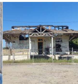
Fig. 4.32. ESTRUCTURA DE MADERA, ANTIGUA ESTACIÓN DE TREN.
