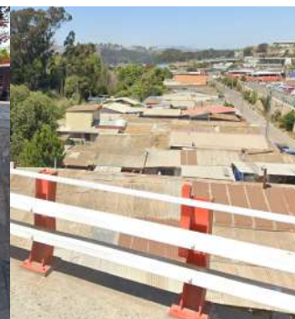
Fig. 4.36. PLANCHAS DE ZINC, TECHUMBRES.
