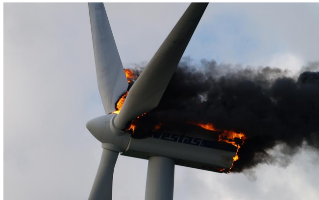
Imagen 2-4 Aerogenerador en situación de incendio
