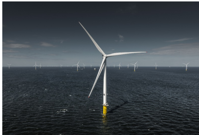
Imagen 2-2 Turbina MHI Vestas V164 de 8MW, Granja eólica Burbo Bank (fuente: www.mhivestasoffshore.com )
