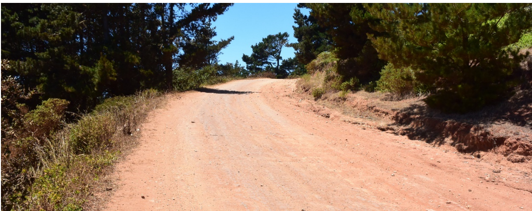
Imagen 4-3 ruta arcillosa "Camino al Faro"
