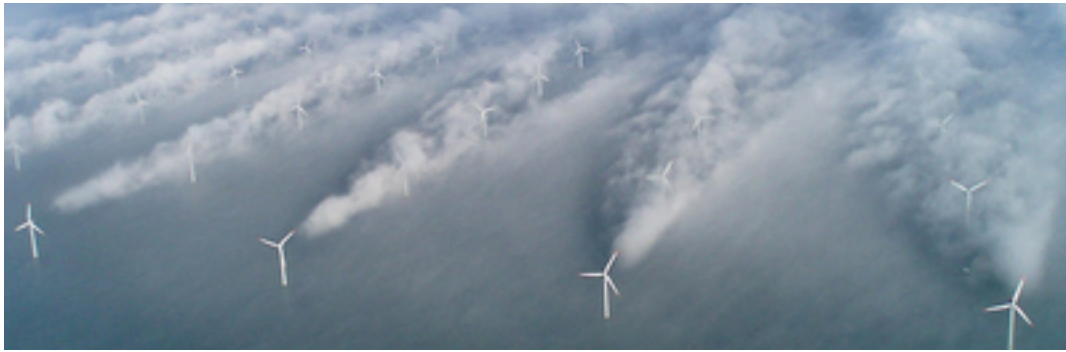
Imagen 6-1 Nubes formándose en las estelas de los aerogeneradores en la planta eólica de Horns Rev, Dinamarca (Fuente: www.windaction.org )
