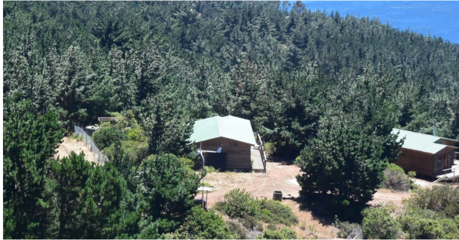
Imagen 4-6 Molino eólico residencial
