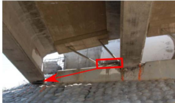
Figura 5.13: Daño observado en el terremoto del Maule en apoyos elastoméricos, Puente Las Mercedes. Fuente: [5]
