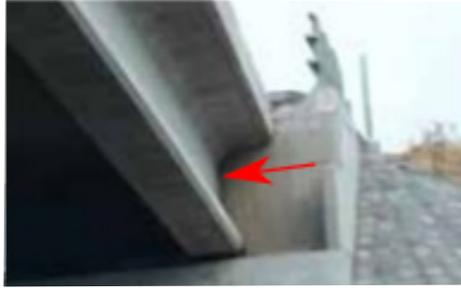
Figura 5.19: Daño en tablero producto del Terremoto del Maule, Puente Las Mercedes. Fuente: [6]
