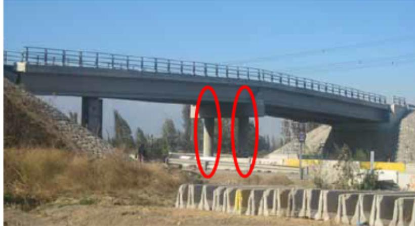
Figura 5.24: Columnas sin rotulación por efecto del terremoto del Maule, Puente Las Mercedes. Fuente: [7]
