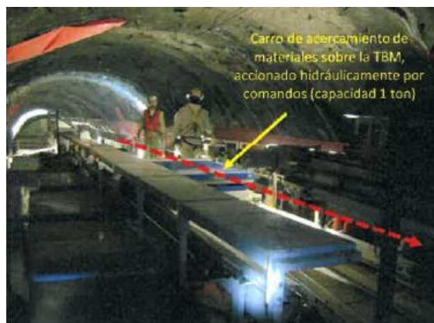
Imagen 3: 3.3 Maquina TBM proyecto San José de Maipo
