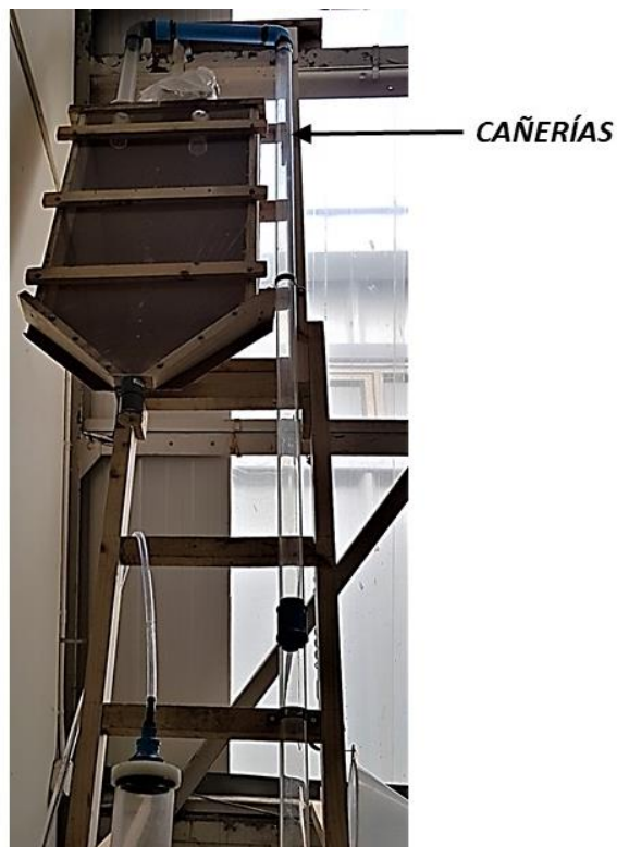
Figura 12: Cañerías montadas a la estructura de madera del sistema de transporte neumático construido.
