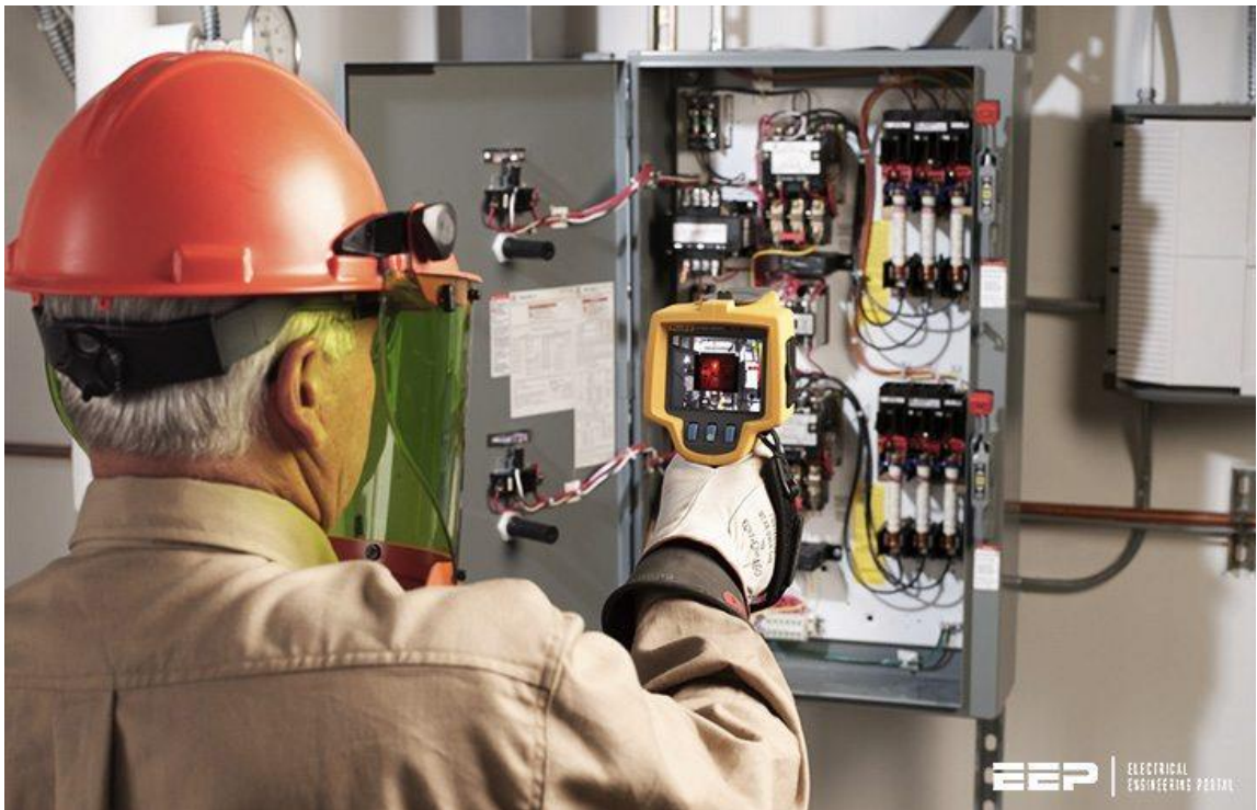
Figura 3-4: Ejemplo de mantenimiento de equipos eléctricos basado en monitoreo de condición
