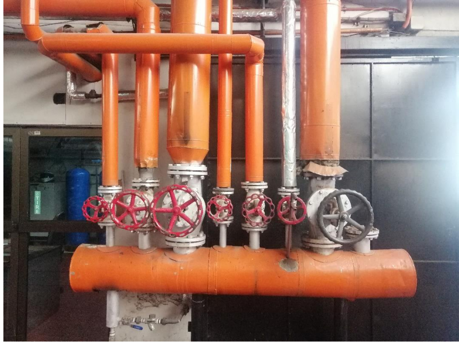
Figura 3-11: Árbol Principal de Distribución de Vapor
