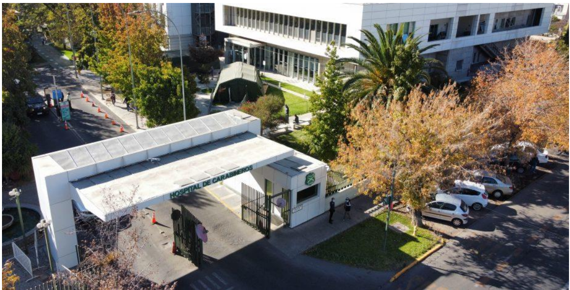
Figura 2-1: Hospital de Carabineros, Av. Antonio Varas N° 2500, comuna de Providencia, Santiago, Chile
