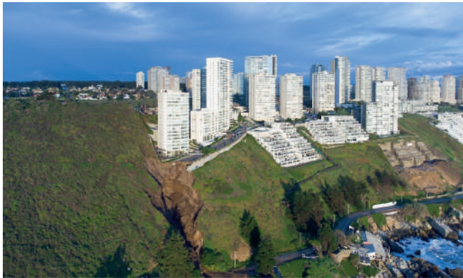
Fig 32 | Socavón edificio Kandinsky, Reñaca fuentes: Cristián Kulczewski Larrain, 2024
