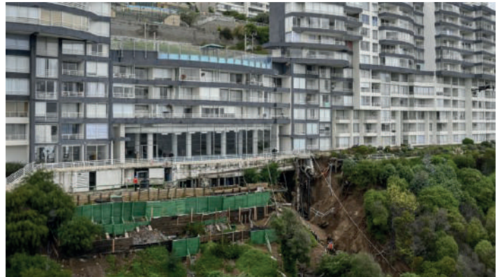
Fig 33 | Socavón edificio Euro Marina II, Reñaca. fuentes: Cooperativa, 2024
