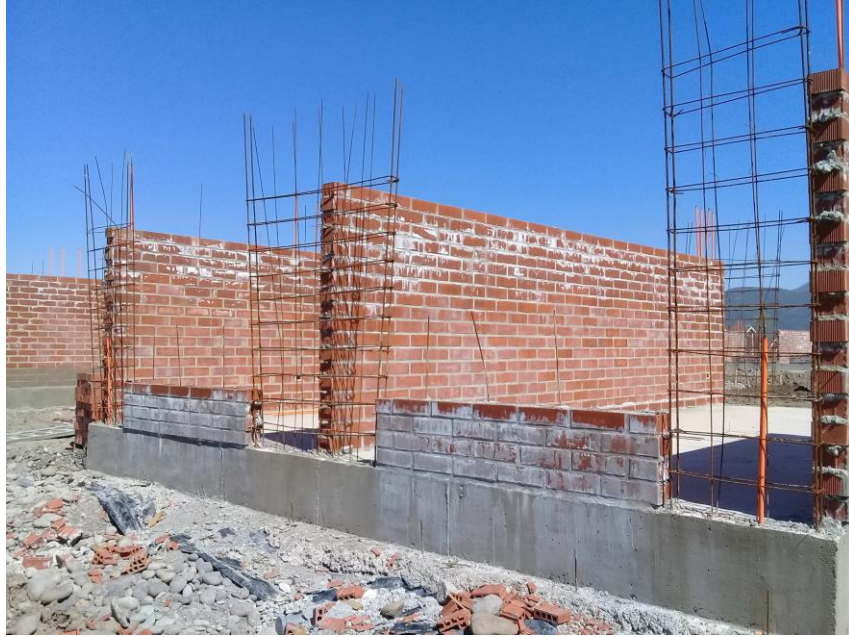
Figura 2-16. Albañilería terminada.
