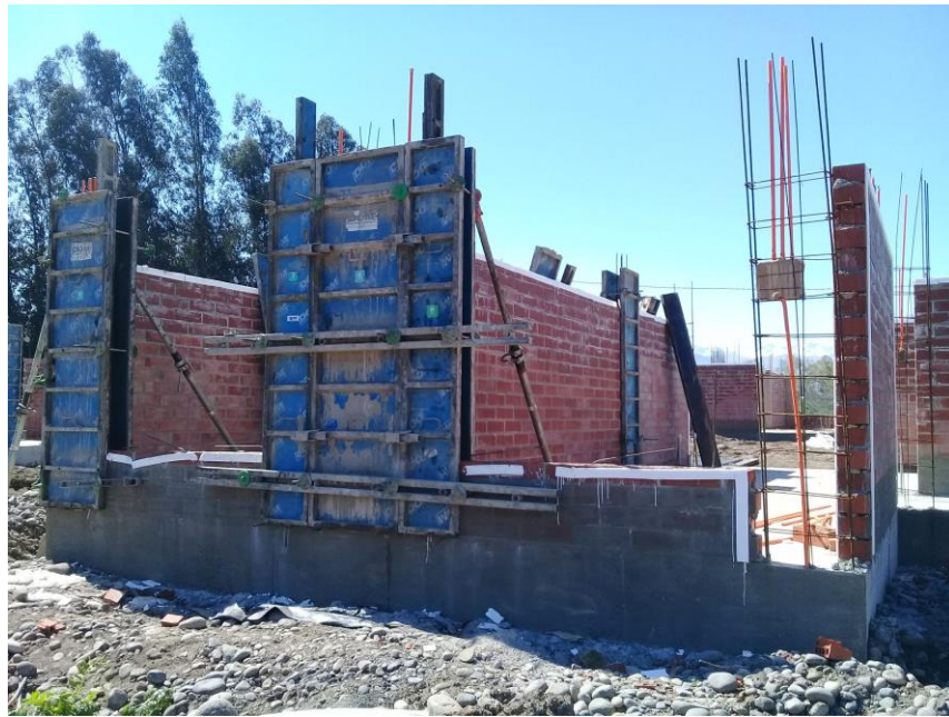
Figura 2-17. Moldaje de Pilares.
