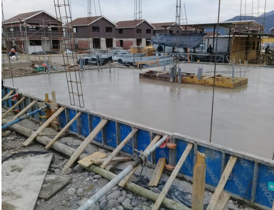
Figura 2-14. Hormigonado "cimiento flotante".
