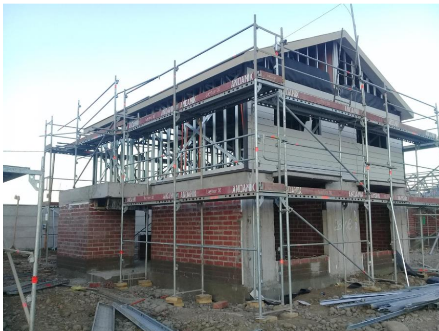
Figura 2-22. Instalación Siding.
