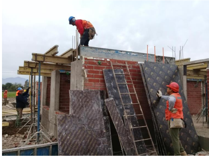
Figura 2-18. Colocación de placas fenólicas.
