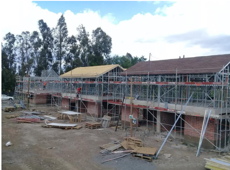
Figura 2-23. Avance construcción techo y cubierta.
