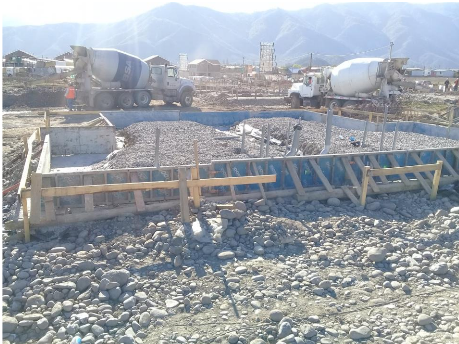
Figura 2-13. Ejecución de "cimiento flotante".
