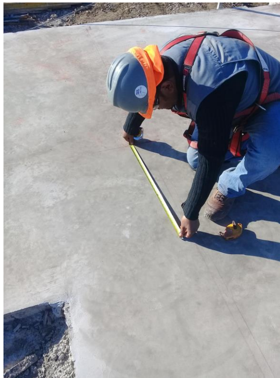
Figura 2-4. Verificando distancias del tabique en la losa.
