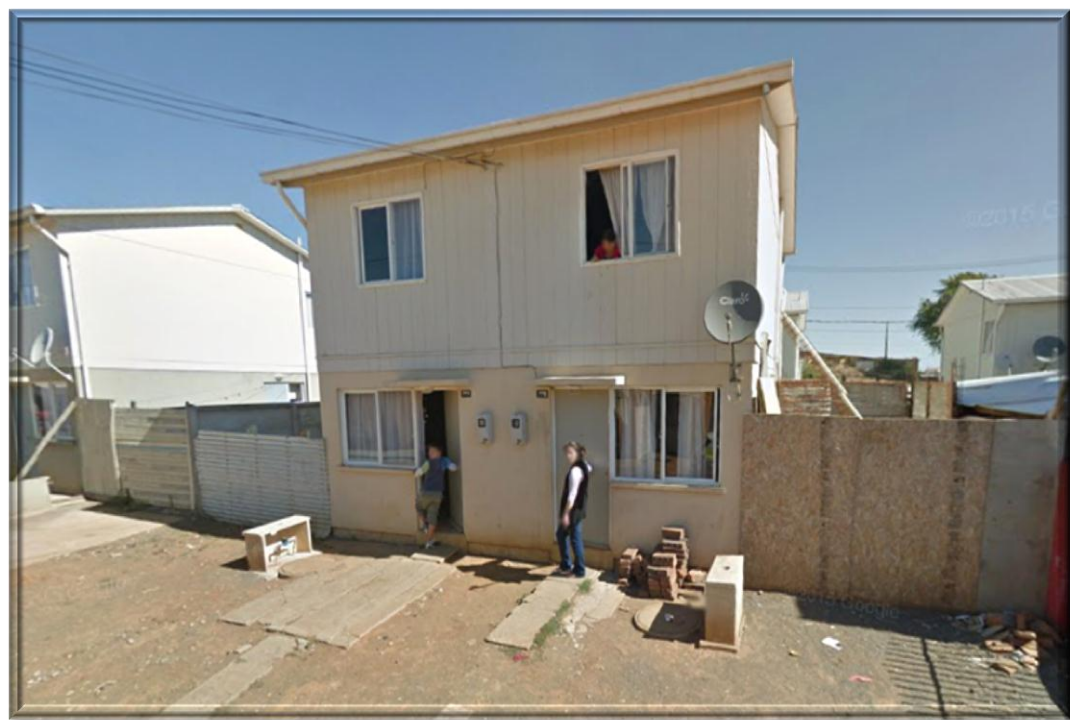
(Figura 1.3 vivienda tradicional pareada, sin modificación)
