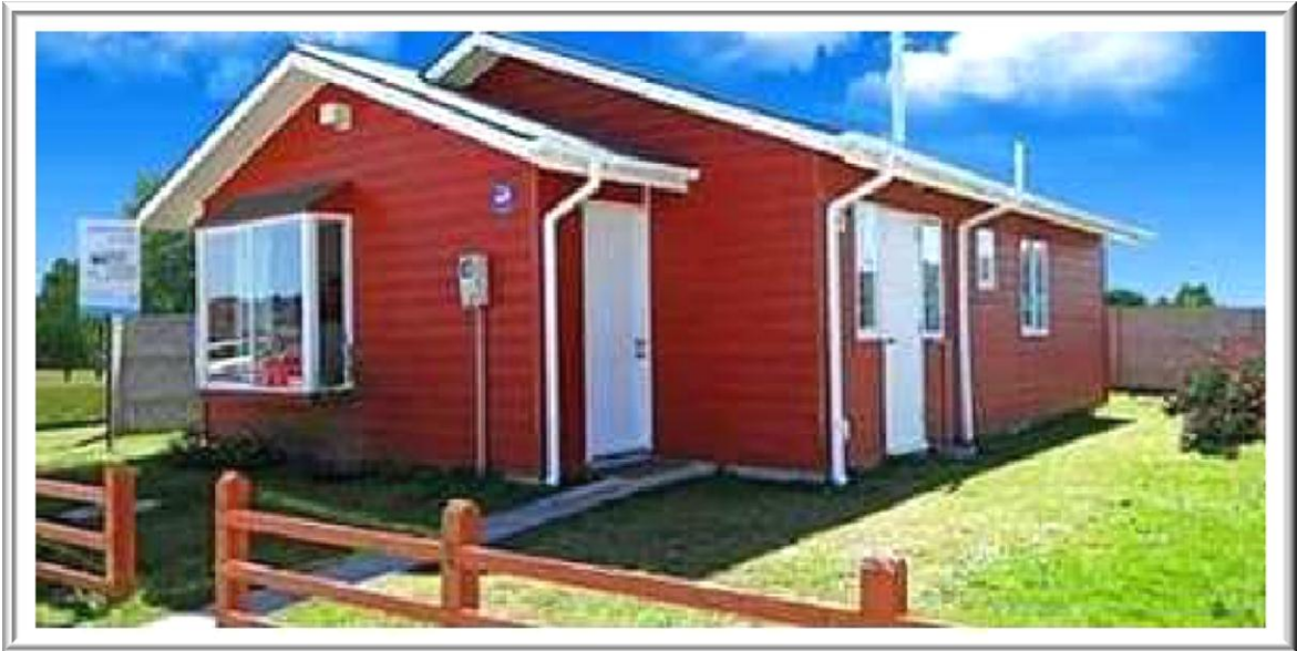
(Figura 1.1 Vivienda Tipología Benjamín Construidas en la región del Bío-Bío, Chile)
