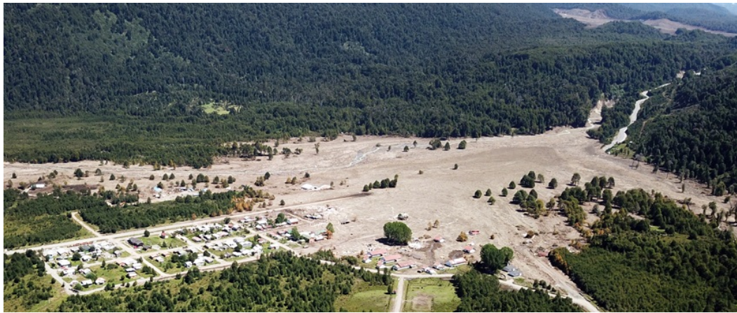
Figura 4.3: Imagen de Villa Santa Lucia después de ocurrido el aluvión. Recuperado de Sernageomin [2].
