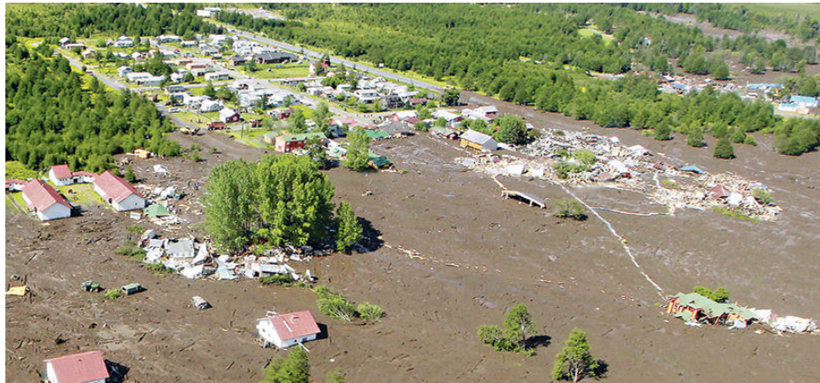
Figura 5.1: Imagen área del aluvión sobre Villa Santa Lucia. Recuperado de Diario La Tercera
