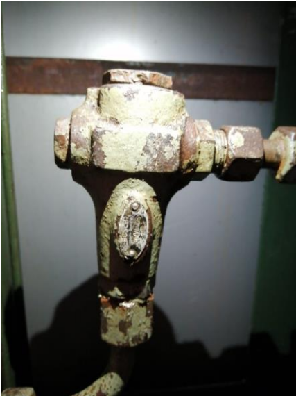
Figura 2-9 Válvula de retención del circuito hidráulico y su simbología Fuente: Elaboración propia
