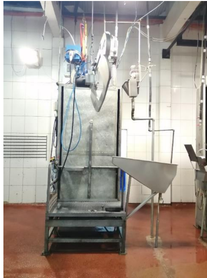
Figura 2-2 Plataforma utilizada en división de canal
