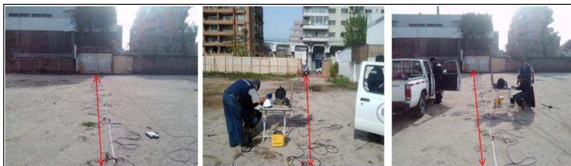
Figura 4-4.- Arreglo de tendido de geófonos para ensayo ReMi.
