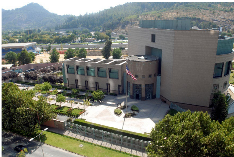
Figura 1.1 Vista aérea Embajada EE. UU.
