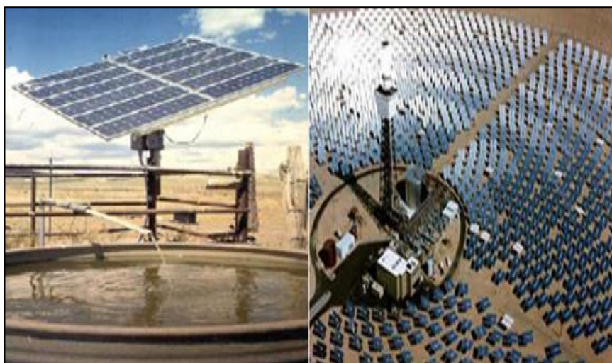
Figura 31: Módulo fotovoltaico para bombeo (izquierda) y huerto solar (derecha)
