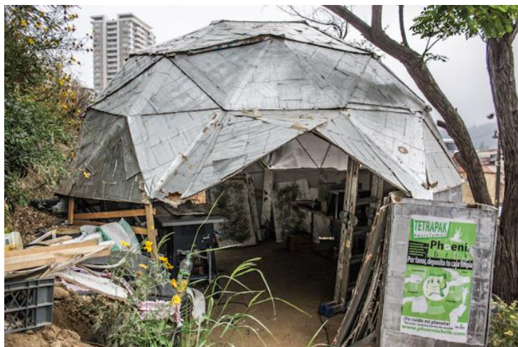
Figura 12: Domo en las instalaciones de Phoenix Brik. Su estructura es de fierros reciclados y su cubierta de planchas en base a triturado de Tetra Pak ®.
