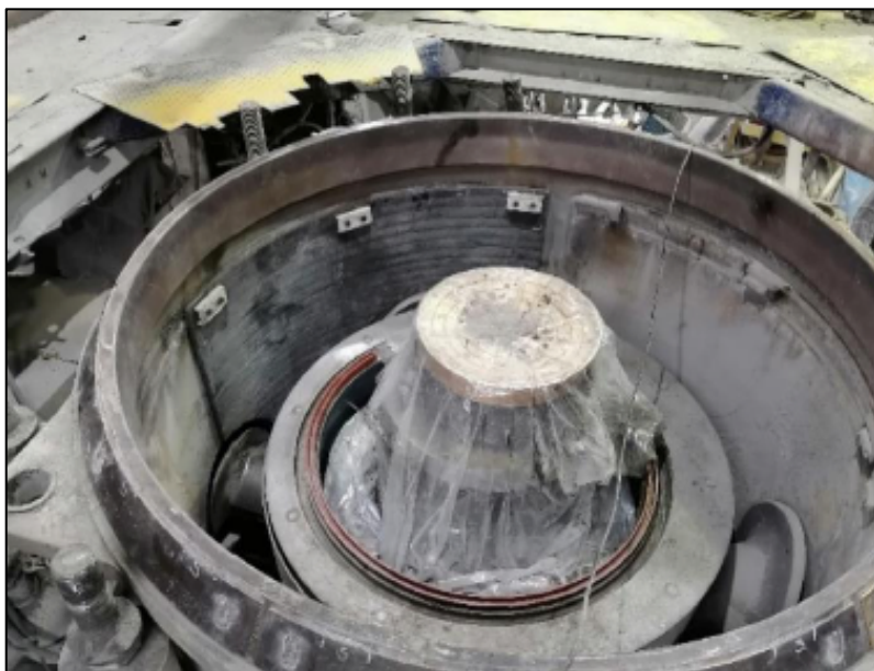
Figura 3-3: Montaje main frame liner bimetálica Recsol, (registro personal).
