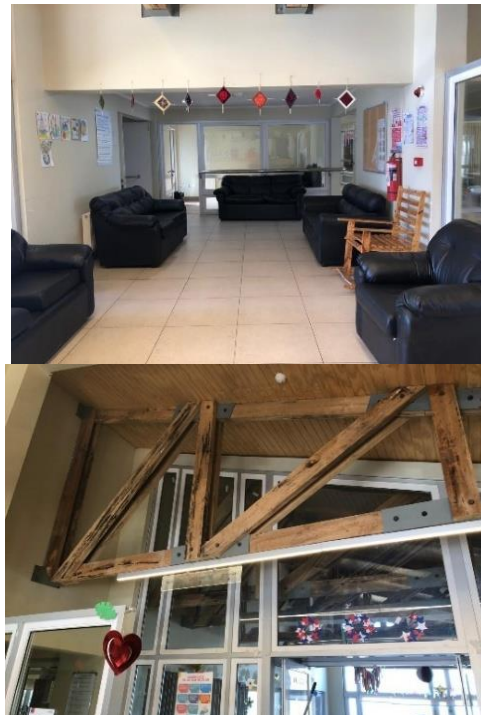
Img 1.5. Edificio ELEAM en La Serena, imágenes interiores
