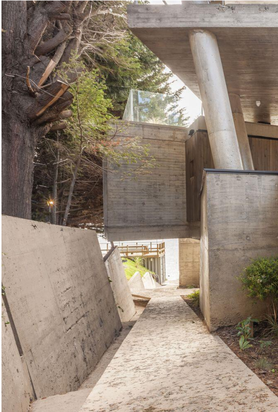
Img 3.13 Fotografía de los accesos universales proyecto Casas WA One Lakes del equipo de arquitectura Vermaasen Arquitectos.
