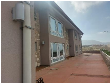
Img 1.8. Edificio ELEAM en La Serena, imágenes de patios Fuente: Elaboración propia de imágenes.
