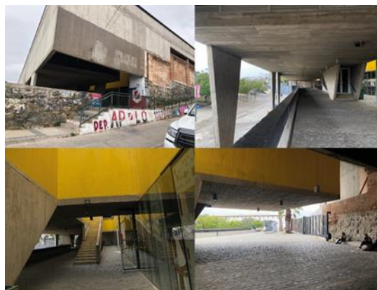
Img 3.5 Collage imágenes del Parque cultural ex - cárcel de Valparaíso, Edificio de cultural.
