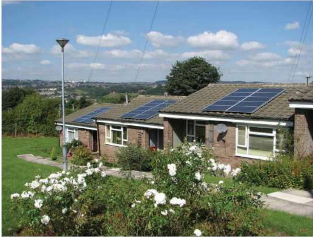
Figura 14: Instalación Fotovoltaica Residencial.
