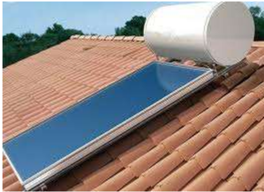
Figura 16: Ejemplo de un colector plano.
