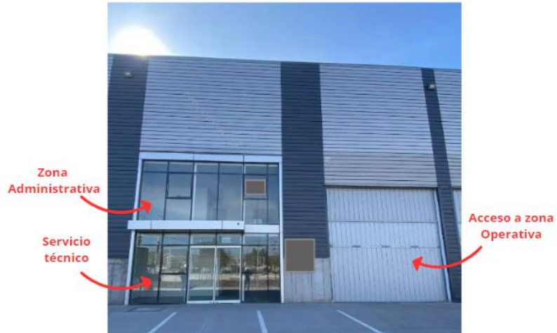
Imagen 2 – Áreas de bodega de ACT S.A.
