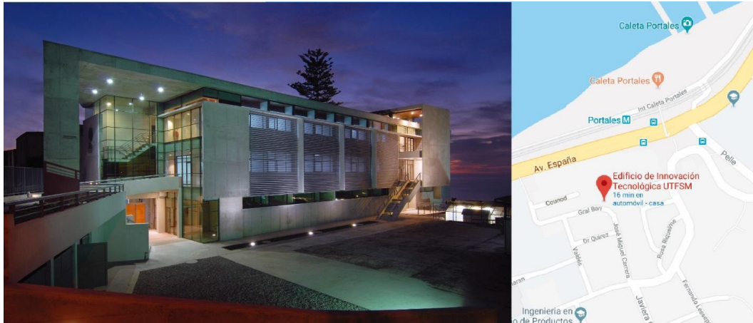
Figura 2. 2 Instalaciones Centro de Biotecnología ubicado en General Bari 699, Valparaíso
